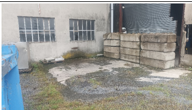
Photographie8 : Aire de lavage bétonnée sans séparateur
